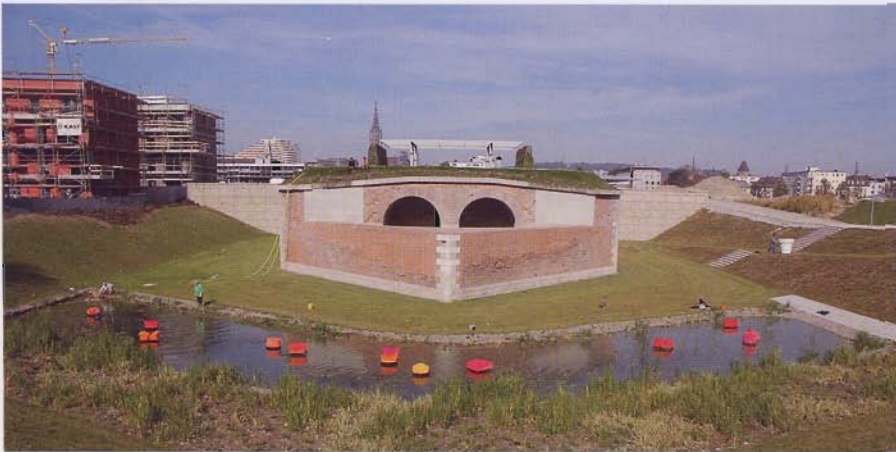
Caponniere im Glacis Baustellenfest
