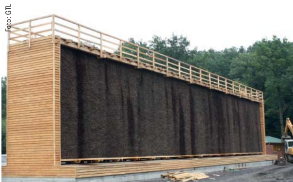
Derzeit wird das Gradierwerk gebaut, über das schon bald die Sole herabrieseln wird.
